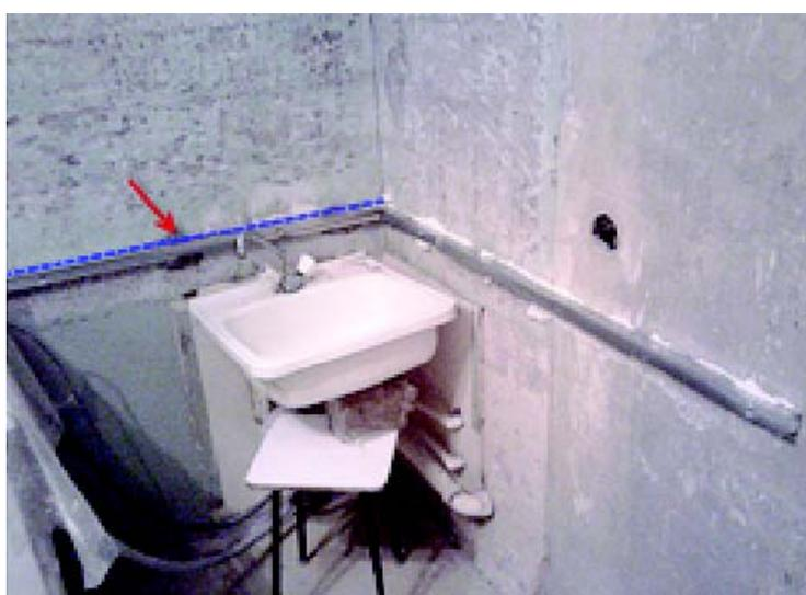
Когда пена высохнет, то срежьте излишки канцелярским ножом. При желании рейки на стены можно прикрепить шурупами, но для этого надо сверлить дырки перфоратором.
