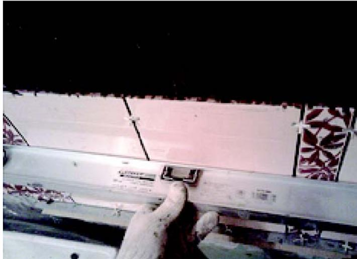
Выложив 3-4 плитки второго ряда, проверьте их по вертикале, с помощью строительного уровня.
