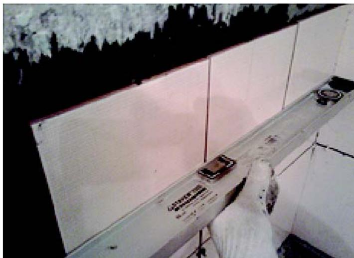
Бывает, что не все плитки одинаковых размеров и чтобы удержать горизонтальный уровень, иногда приходится подкладывать под плитки разные вставки из картона (например, от коробки для плиток), тем самым компенсируя отклонения.
