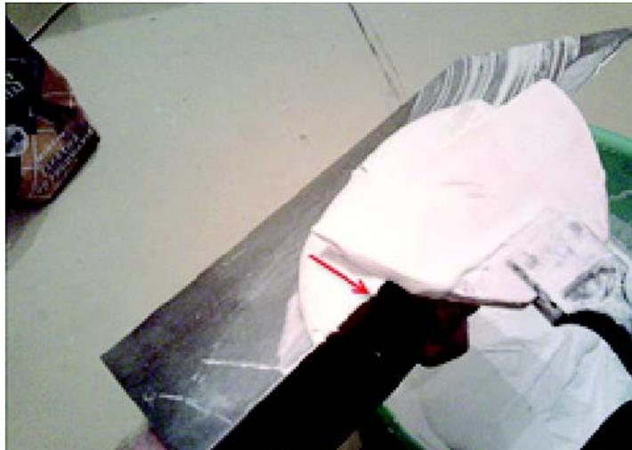
Втирайте затирку глубоко в шов. Делайте движение шпателем сначала под углом, затем вдоль шва.
