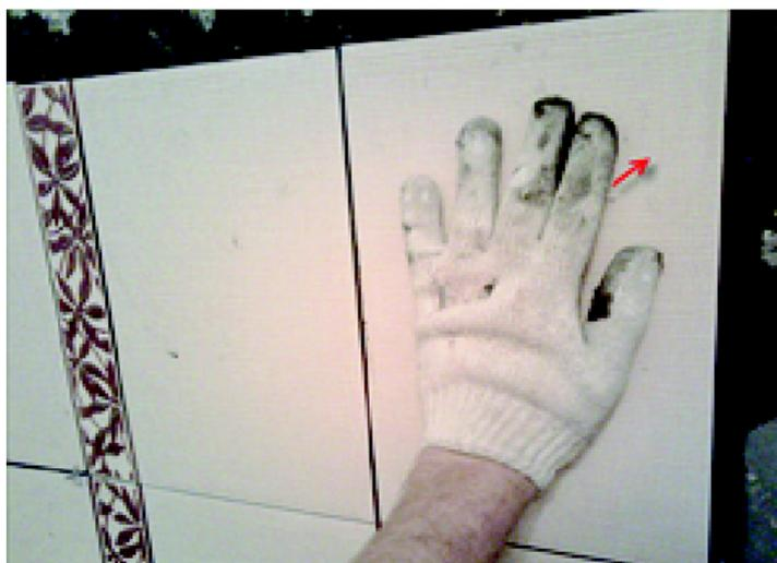
Излишки клея удаляйте сразу, пока он не затвердел. Чтобы плитки хорошо держались, клеевой раствор должен заполнять всю поверхность плитки.
