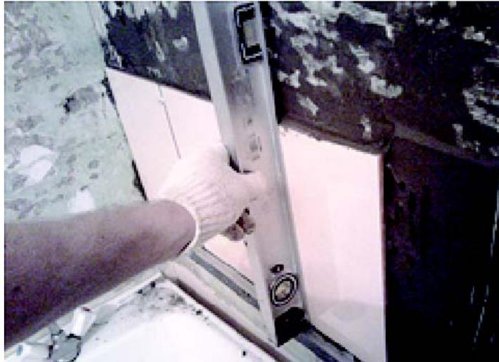
Все плитки должны располагаться в одной плоскости. Чтобы проверить это, приложите уровень к плоскости плиток и посмотрите визуально, чтобы нигде между плитками и уровнем не было зазора. Если большие зазоры есть, то подкорректируйте плитки.
