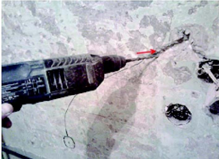
Сделайте отверстие перфоратором для внутренней розетки и подравняйте внутри цементной смесью (чтобы отверстие получилось круглое) .
