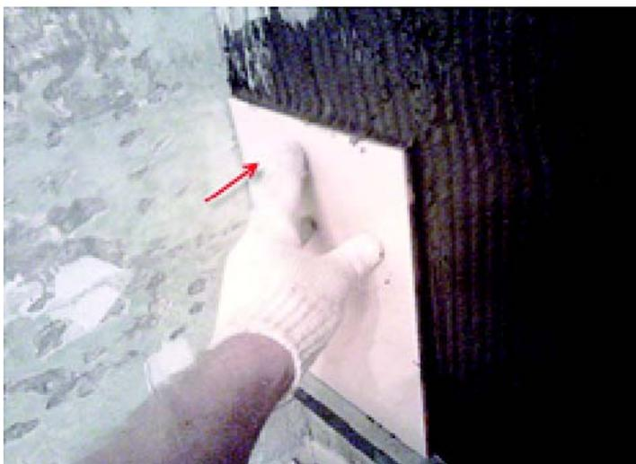
С помощью строительного уровня проверьте, чтобы плитка была строго вертикально. Если стены имеют сильное отклонение по вертикале, то при выкладывании плитки на кухне, строгим вертикальным положением можно пренебречь и выровнять плитку визуально по стене.
