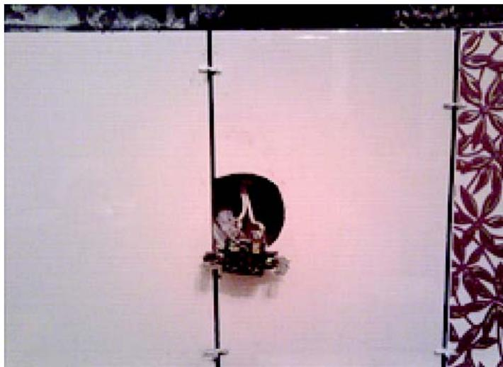
Приступаем к выкладыванию плитки на другой стене. Нанесите клей на стену и разровняйте с помощью зубчатого шпателя на ширину трёх плиток.
