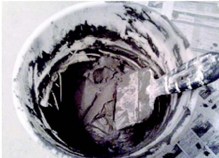
С помощью стальной гладилки нанесите клей на стену, толщиной примерно 8-10 мм и чуть выше уровня высоты первого ряда. Если, например, плитка размером 20x30 см, то нанести клей до высоты 40 см.
